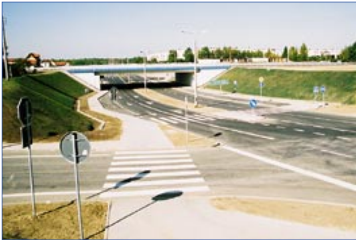
Fot. 6. Skrzyżowanie DK-1 z ul. Sikorskiego w Tychach. Jezdnie o długości po około 100 m każda zostały zawieszono nad upłynionymi filami. Zastosowano kwalifikowane GPwRW.
