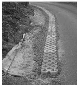
Fot. 6. Zmiana rowu na D.F. z jednoczesnym wykorzystaniem górnej pości D.F. jako chodnika dla pieszych
