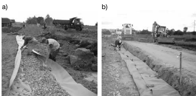
Fot. 4. Montaż D.F.: a) zamykanie drenu; b) dren zamknięty
