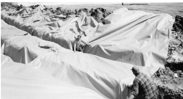
Fot. 8. Podwójny D.F. stanowiący przyporę dla budowanego nasypu
