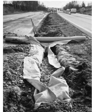
Fot. 3. Nieosłonięte wypełnienie drenu najczęściej ulega częściowemu zamuleniu przed zakończeniem robót
