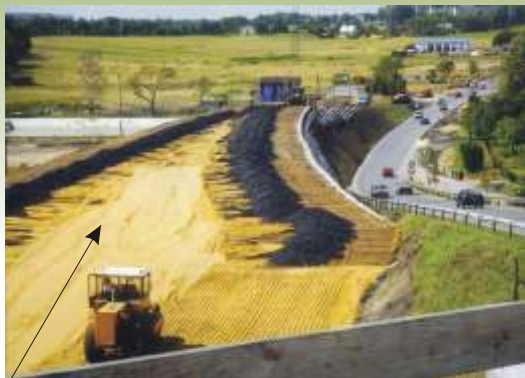
KONSTRUKCJA NOWEGO NASYPU ZBROJONEGO
