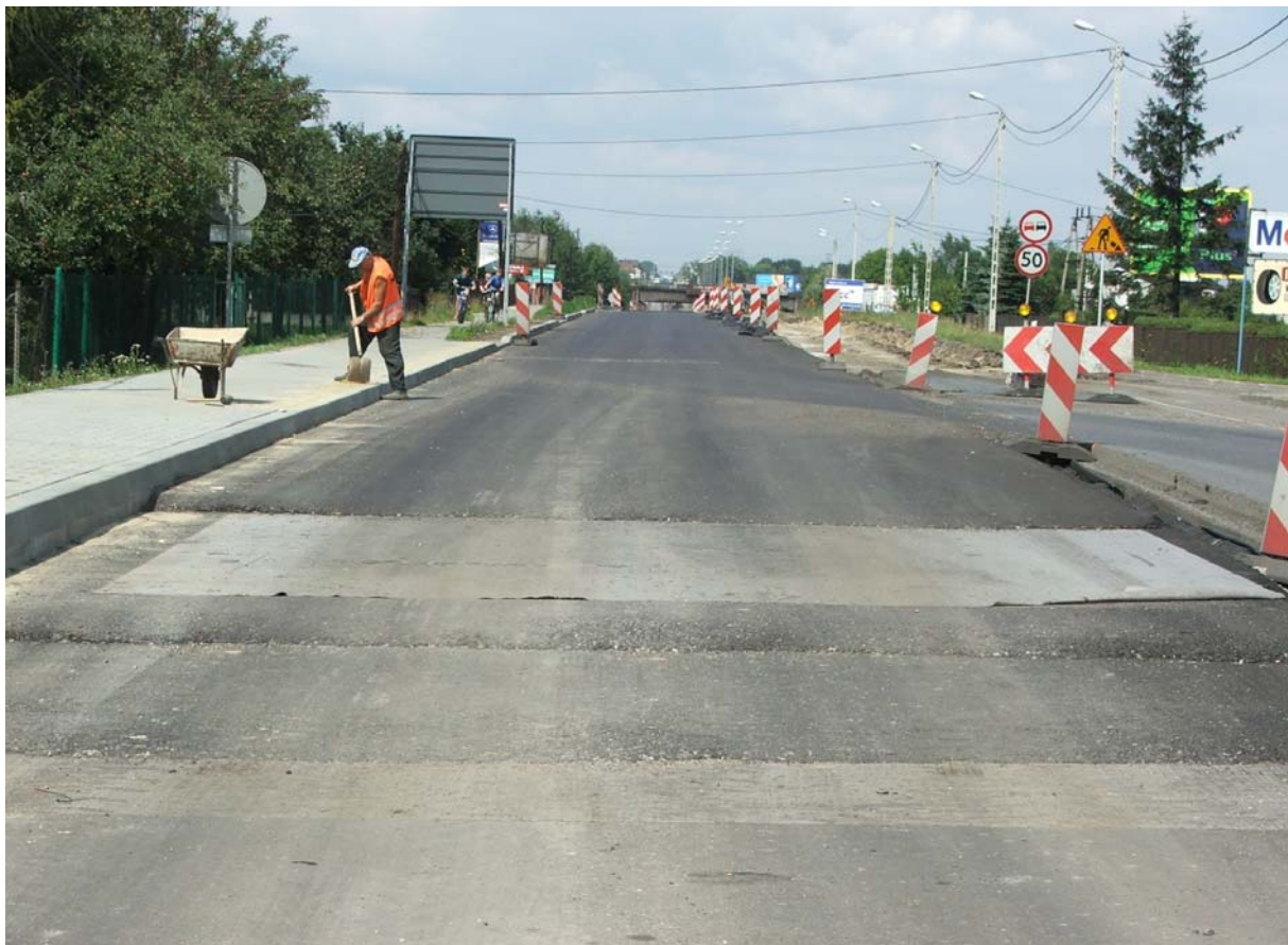
Rys. 7. DK-44 jako przykład efektywnej rehabilitacji Drogi Krajowej narażonej na wpływ eksploatacji górniczej.
