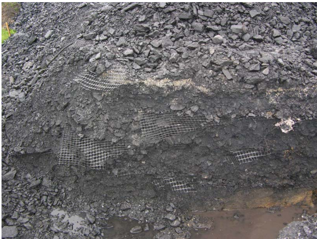
Rys. 4. Zastosowane geosiatek o tzw. „sztywnych węzłach” w obiektach usytuowanych na obszarze ROW’u.
