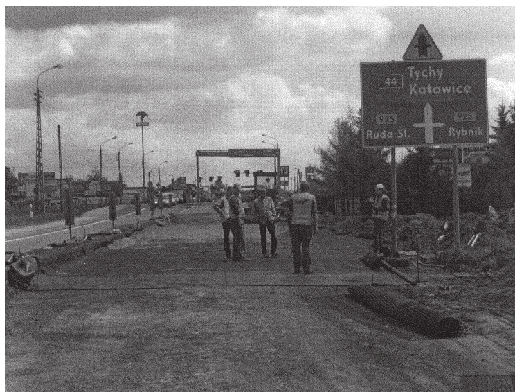
Fot. 5. Rekonstrukcja Drogi Krajowej nr 44 na odcinku narażonym na występowanie szkód górniczych I, II, III oraz IV kategorii, jak również przebiegu dwóch uskoków: knurowskiego i makoszowskiego
