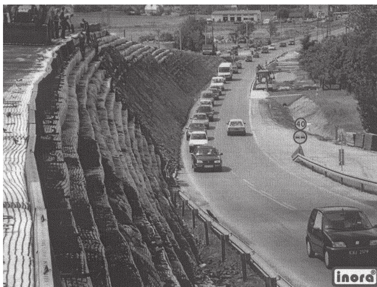
Fot. 3. Najazd po stronie zachodniej w trakcie realizacji. Widoczne warstwy konstrukcyjne, pozycjonowane szalunki oraz wielkości kątów nachylenia skarpy północnej
