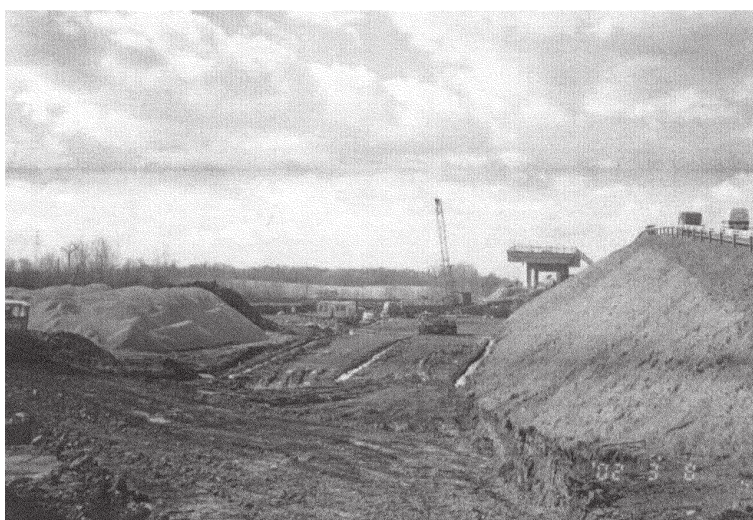
Fot. 2. Jastrzębie-Zdrój, DW 933. Widoczne dreny francuskie przygotowane pod najazd wschodni.
