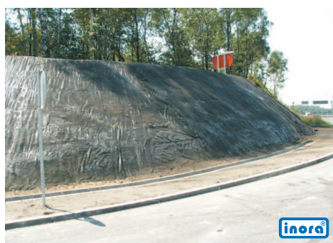
zazielenianie powierzchni skarp nasypu metodą hydroobsiewu;
