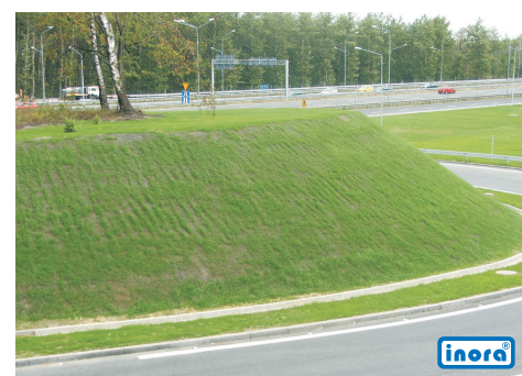
efekt zazielenienia skarp po 14 dniach od wykonania hydroobsiewu;
