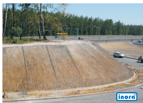
układanie siatki HaTe ® 23.142;
