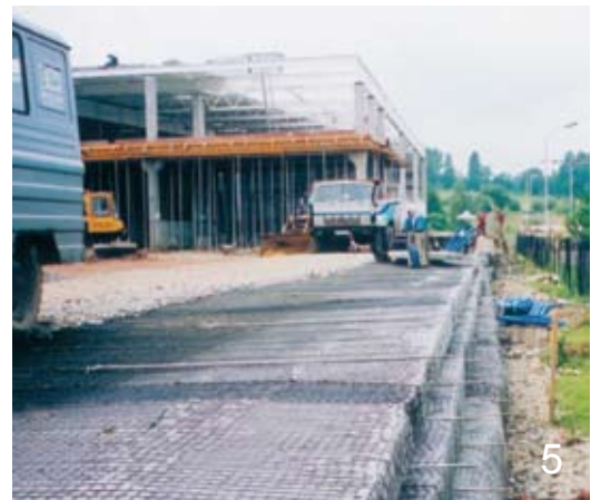
Uformowana kolejna warstwa stromego nasypu
