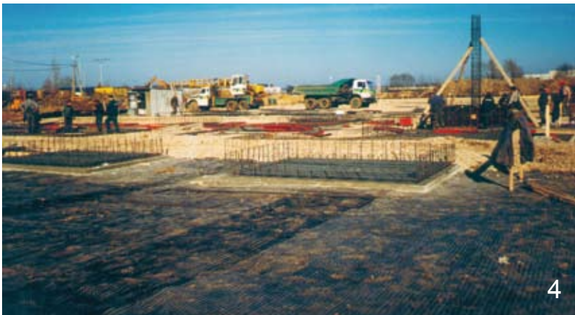
Zbrojenie terenu (pasmami ułożonymi na krzyż) geosiatką o \text{UTS}=250\text{kN/m} ; wzmocnienie podłoża pod stopy fundamentowe żelbetowych słupów
