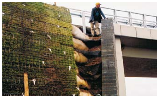
Fot. 3. Wznoszenie wraz z kotwieniem ściany oporowej
