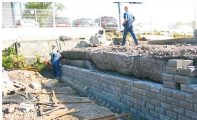
Fot. 1. Wznoszenie samostatecznej ściany biernej
