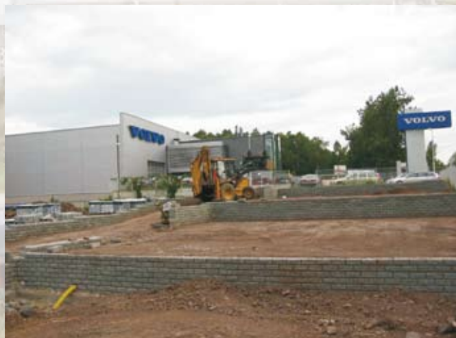
Fot. 2. Wykonane trzy poziomy parkingów wystawowych
